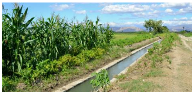
Le PCD c'est aussi la rénovation de 800m du canal d'irrigation de la ferme « Twa bòn »
